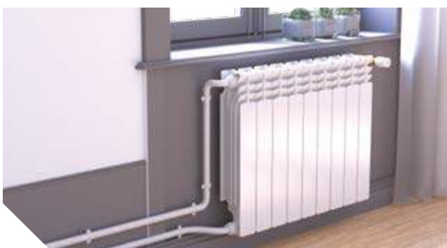
Водоснабжение и отопление
